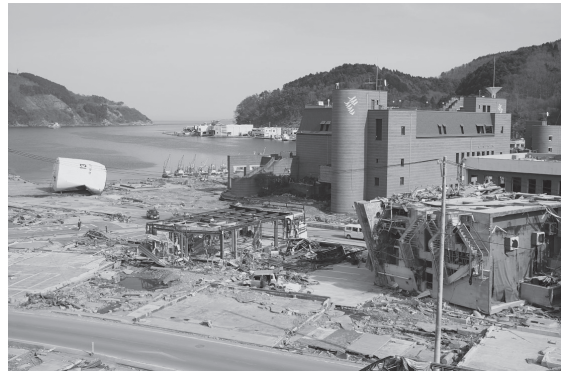
建物の外側だけが残ったマリンパール
