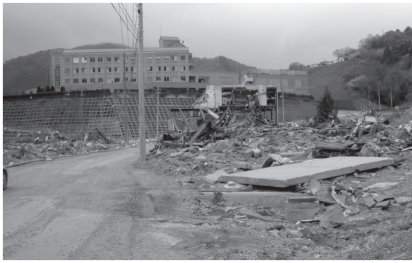
女川町立病院（18メートルの高台にある建物の一階まで浸水）
