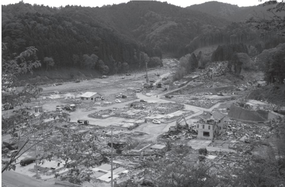
市街地はすべて壊滅。沿岸部では引き波の巨大な圧力で鉄骨が海の方を向いて倒れ、ビルが横倒しとなり、鉄筋のビル以外は基礎を残してほとんど何も無い状態でした。去を急ピッチですすめていました。
